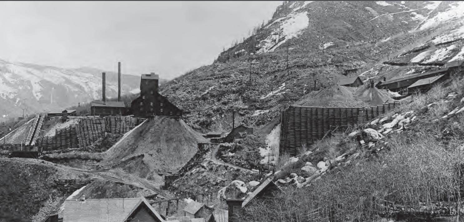
El Deep Shaft fue una impresionante operación emblemática, que destacaba entre todas las demás en el panorama minero industrial de Aspen a finales del siglo XIX. La planta en la superficie incluía un sistema de elevación a vapor, un sistema de agua, una red ferroviaria y grandes naves de clasificación de mineral. En el exterior, muros de entramado de madera de 80 pies de largo y 20 pies de alto retenían el mineral de baja graduación y la roca estéril. / Aspen Historical Society
