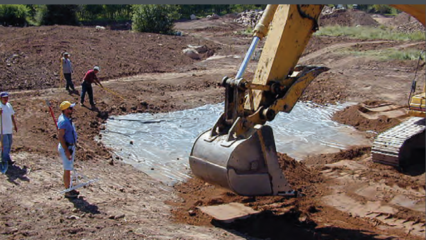
Se utilizó maquinaria pesada en los márgenes de los humedales. Se colocaron materiales naturales y revestimientos para retener el agua. / Aspen Parks Department
