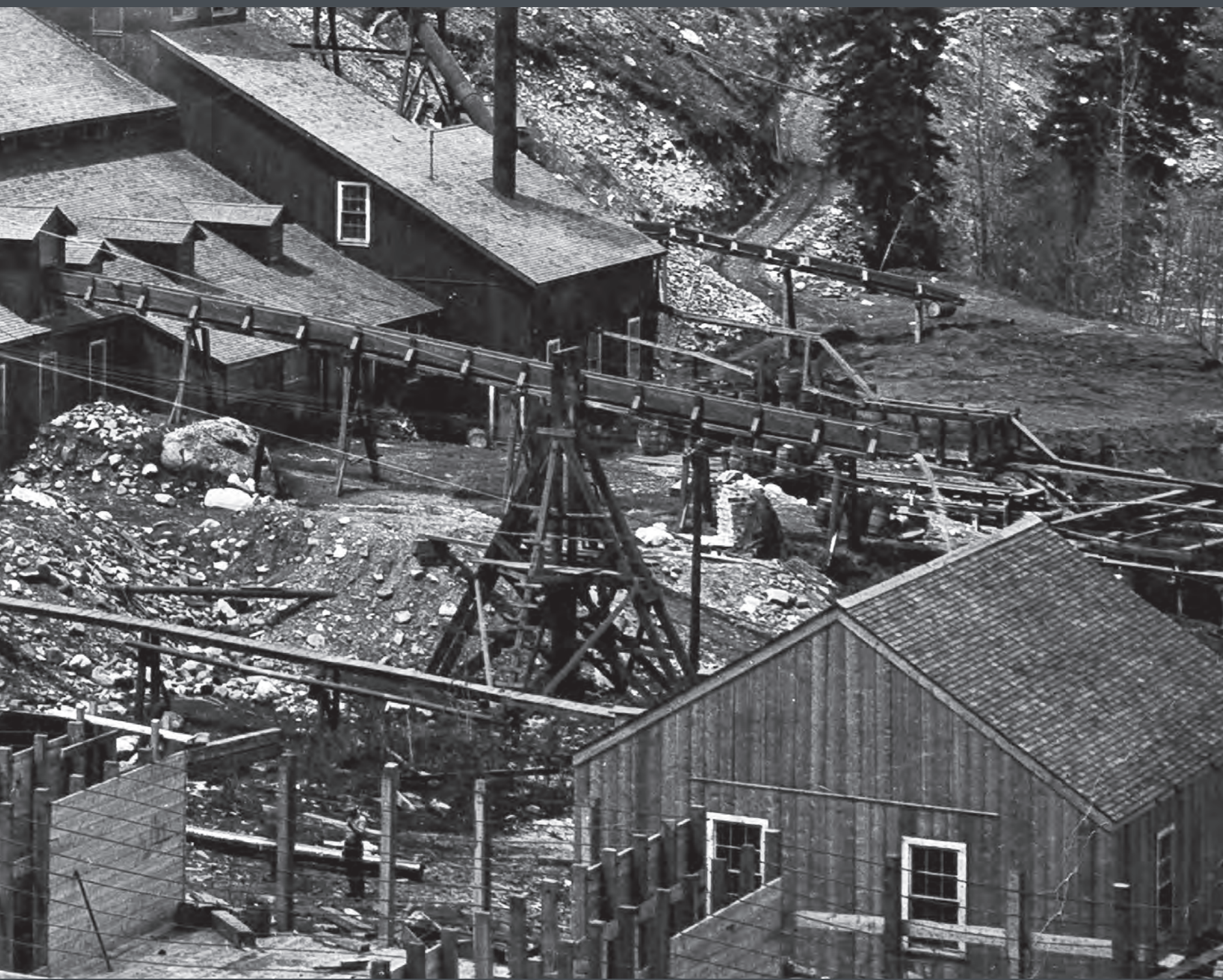
Aunque parecía relativamente pequeña entre el complejo de edificios, tanques, montones de escombros, tuberías elevadas, rampas y sendas de madera, la torre de perforación de 26 pies de altura era una estructura única e importante tanto en su función como en su diseño. / Colorado Historical Society
