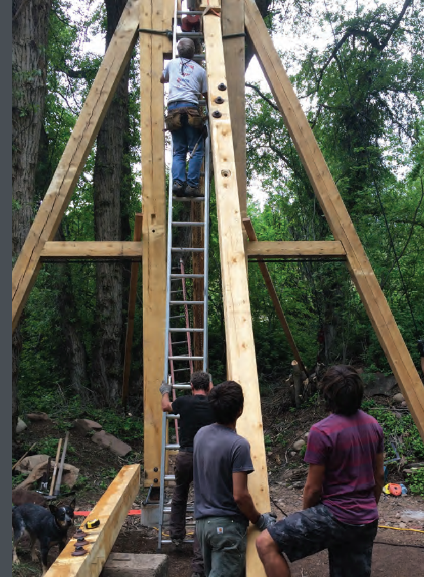
Cuando a finales de la década de 1890 se transportaban rutinariamente troncos de más de 100 pies de largo a los aserraderos, había que cortarlos para que las sierras pudieran manejarlos. A continuación, los carpinteros cortaban las maderas acabadas a la longitud necesaria. Reproduciendo el proceso histórico, se cortaron troncos de abeto Engelmann de Grand Mesa, se aserraron en forma cuadrada y se empalmaron con juntas a mano para formar los montantes de 7" x 11" de la nueva torre. La réplica de la torre de perforación se levantó en junio de 2016 utilizando un poste de elevación y un sistema de poleas. / Aspen Parks Department
