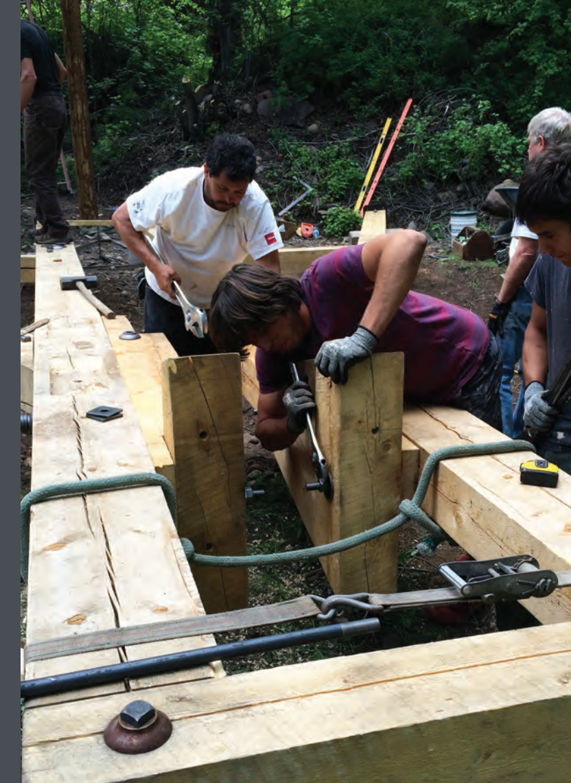
Cuando a finales de la década de 1890 se transportaban rutinariamente troncos de más de 100 pies de largo a los aserraderos, había que cortarlos para que las sierras pudieran manejarlos. A continuación, los carpinteros cortaban las maderas acabadas a la longitud necesaria. Reproduciendo el proceso histórico, se cortaron troncos de abeto Engelmann de Grand Mesa, se aserraron en forma cuadrada y se empalmaron con juntas a mano para formar los montantes de 7" x 11" de la nueva torre. La réplica de la torre de perforación se levantó en junio de 2016 utilizando un poste de elevación y un sistema de poleas. / Aspen Parks Department
